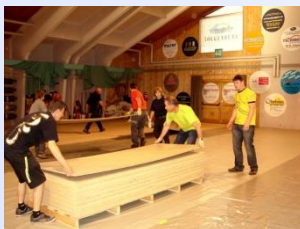
Verlegen der Bodenplatten
