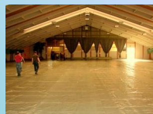
Der Plastik ist verlegt
